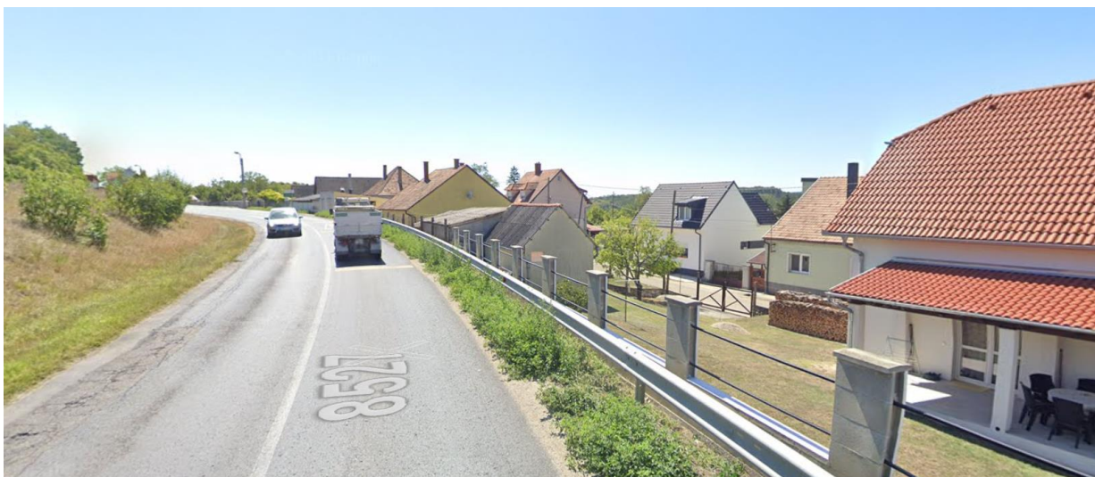
Utcakép a Vámház sor (8527 j. út) Felsőszikla sor közeli szakaszáról
