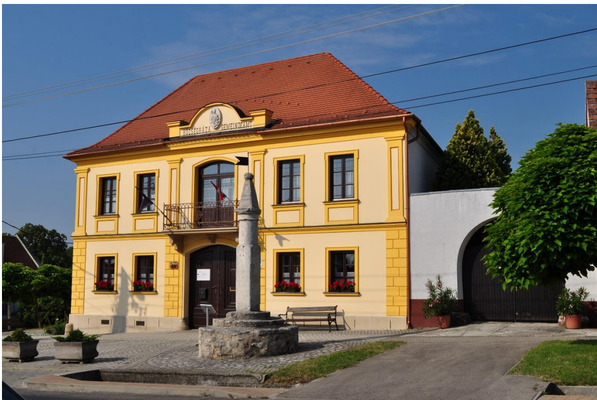
Fő utca 139. sz. ház (községháza) előtt álló pellengér hrsz.: 866
